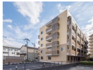
一休江坂 68室 鉄骨造 (2022年2月18日竣工)
