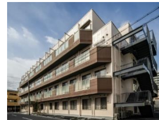
ヒビオ住吉 78室 (旧病院) (2025年2月3日竣工)
