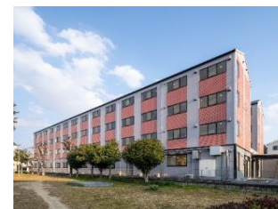
ウールズ大日 77室 (旧社員寮) (2025年1月27日竣工)
