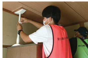
新たな備えサポート隊による、家具転倒防止器具の設置
