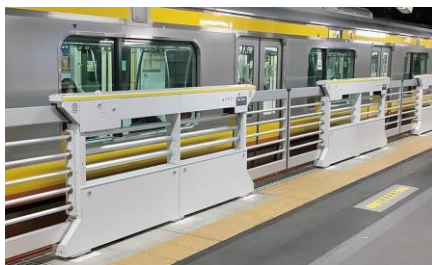
スリットフレームホームドアの設置
