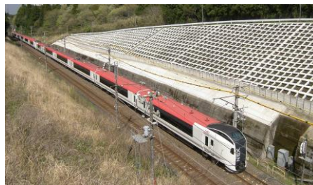
沿線斜面の補強
