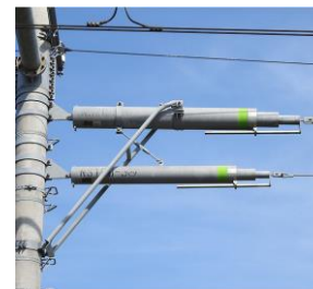
架線設備の更新
