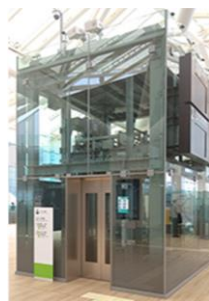
エレベーターの設置
