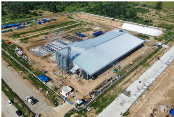
本工場の建設場所 全景
