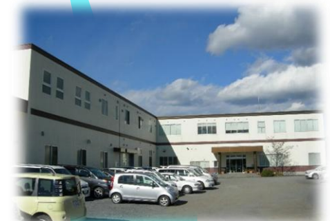
関東工場・東日本営業所
