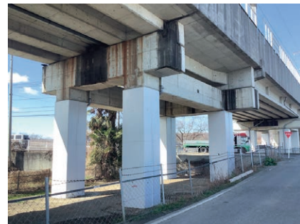
高架橋柱耐震化工事
