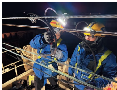
夜間の架線メンテナンス
