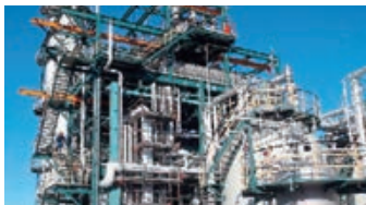
四日市工場 S-SBRプラント
