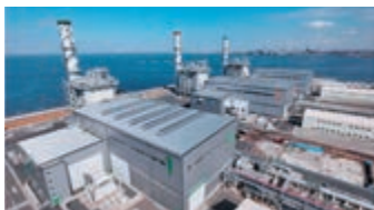
五井火力発電所
