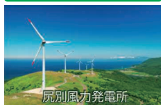
尻別風力発電所
