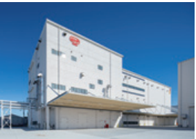
栃木工場水性接着剤製造所
