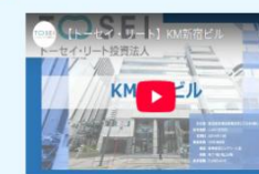
【トーセイ・リート】KM新宿ビル
