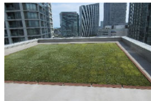
横浜プラザビル(屋上部分)
