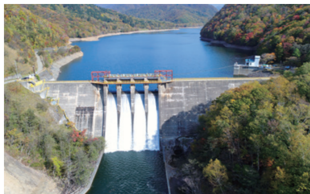
第3発電所ダム
