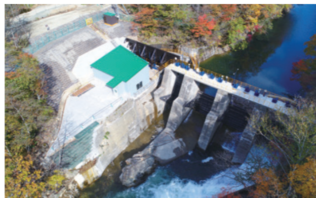
第2発電所堰堤
