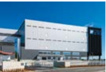
関西工場・関西ハブセンター
