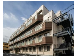
ヒビオ住吉 78室 (旧病院) (2025年2月3日竣工)
