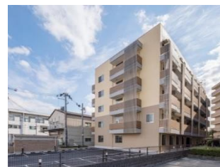
一休江坂 68室 鉄骨造 (2022年2月18日竣工)
