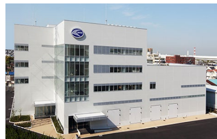
研究開発本部 研究所 先端技術棟 (埼玉県さいたま市)
