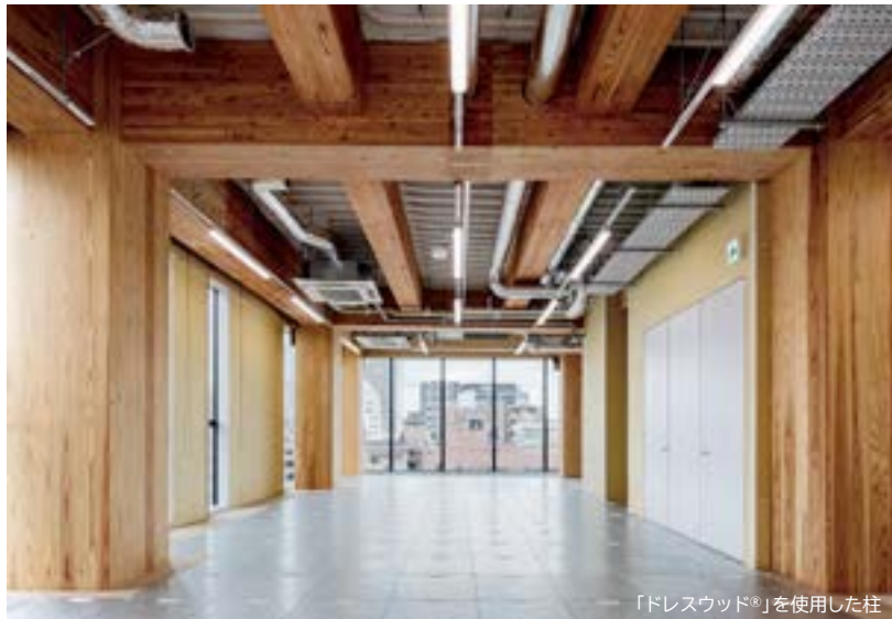
「ドレスウッド®」を使用した柱
