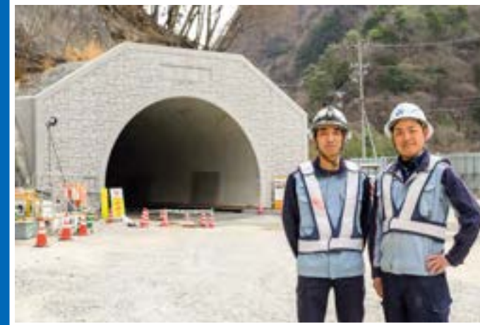
現場の若手社員(トンネル坑口)
