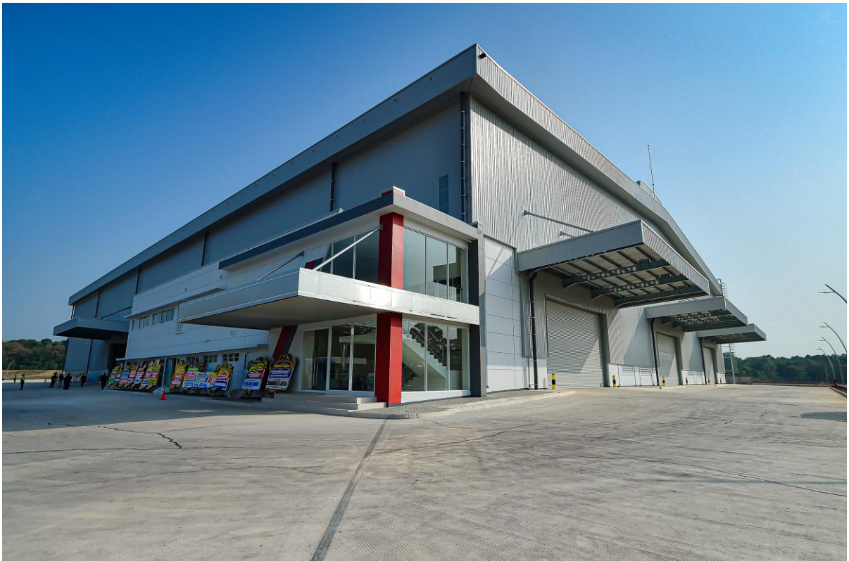
インドネシア第二工場建屋
