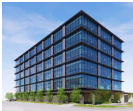
(仮称)JR肥後大津ビル (2027年春竣工予定)
