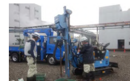
設備設置前の自主調査
