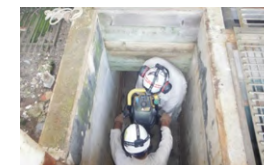
使用を廃止する排水ピット下の自主調査
