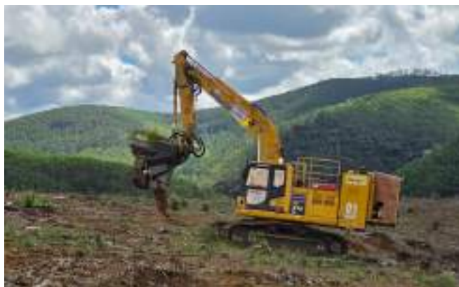
植林作業を行う油圧ショベル
