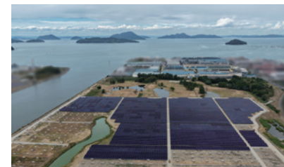
工事進行中の太陽光発電システム（画面上部 詫間事業所）
